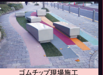
ゴムチップ現場施工
