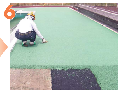
6 熱ゴテで仕上げ
